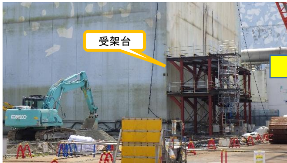
(写真1-1) アンカー掘削装置の受架台設置状況 (令和3年8月30日撮影)
