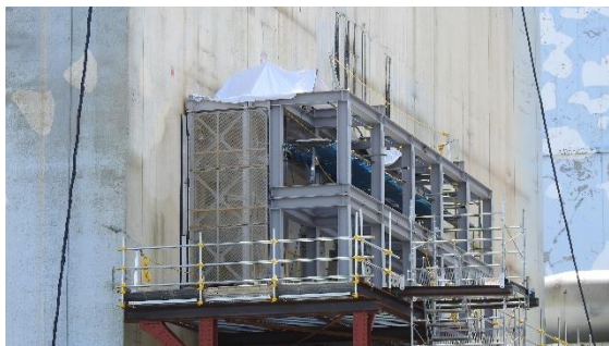
(写真1-3) アンカー削孔装置 (拡大)
