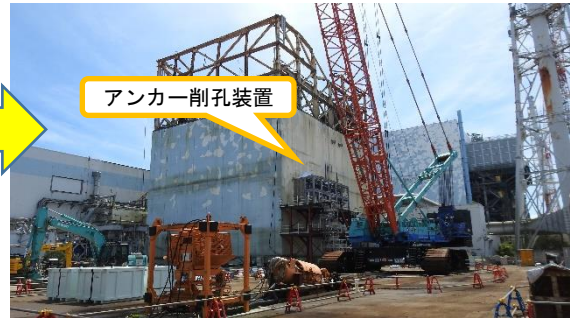
(写真1-2) アンカー削孔装置の据え付け状況 (令和3年9月10日撮影)
