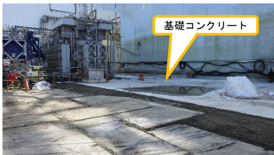
(写真2) 原子炉建屋北側のコンクリート基礎 工事の状況
