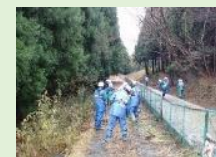
用排水路の維持管理作業
