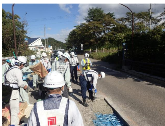
④コンクリート打設
