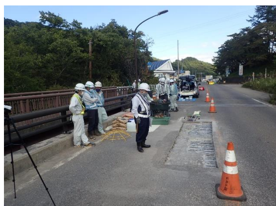
②コンクリート打設前
