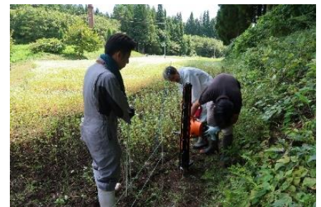
(スマートフェンスの設置)
