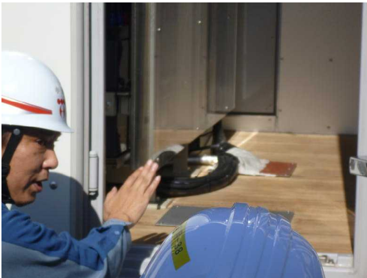
○ガスタービン発電機車の小動物侵入対策
