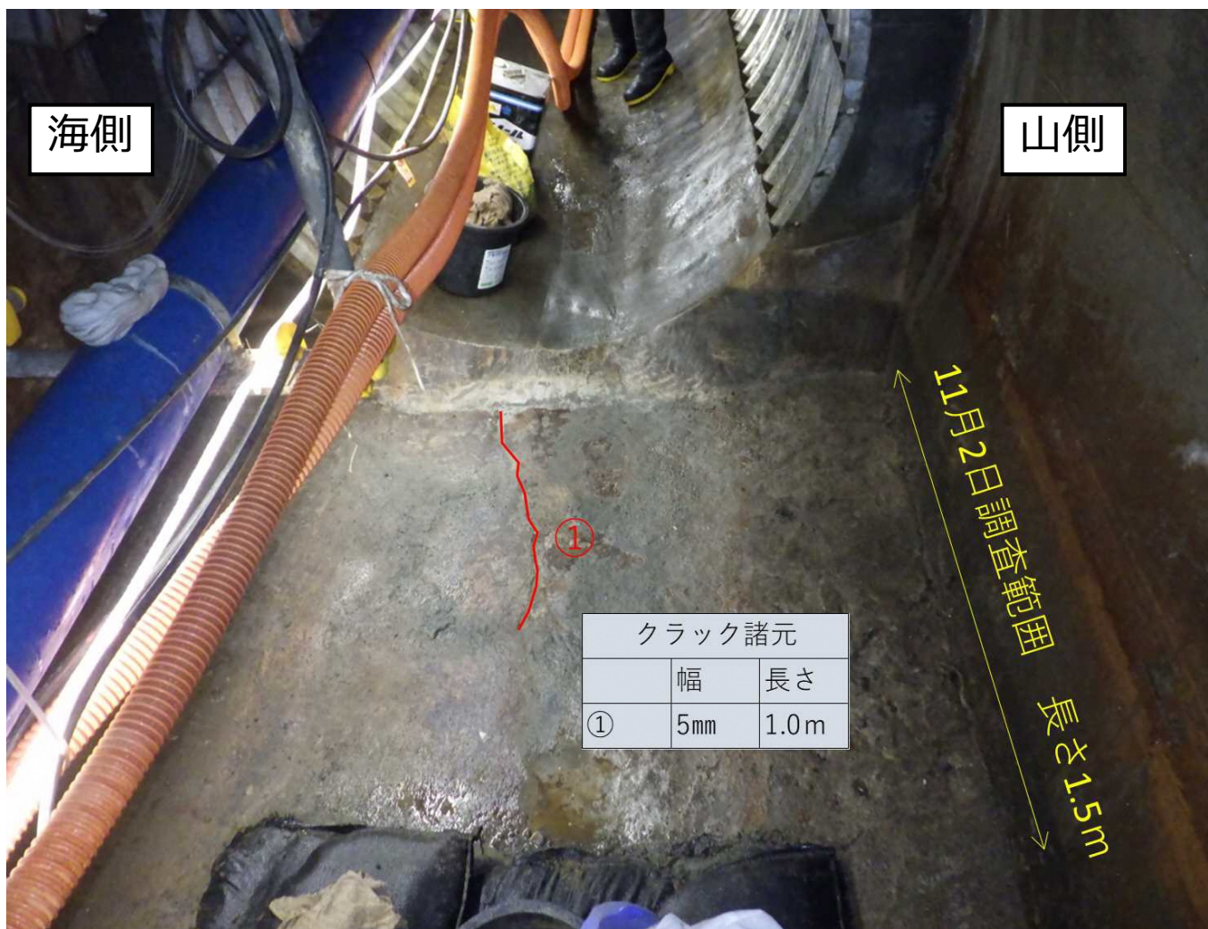
K排水路内部ドライアップ区間 クラック調査結果
