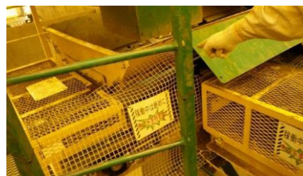
可動部へのネット敷設状況
