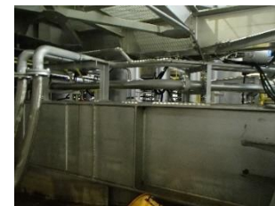
仮設灰処理施設(その1)復旧状況
