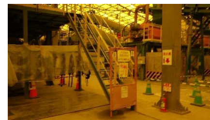
ガードフェンスの設置及び施錠管理状況、正・副担当者の掲示
