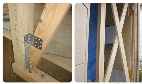
＜耐震改修の実施例：筋交い補強＞
