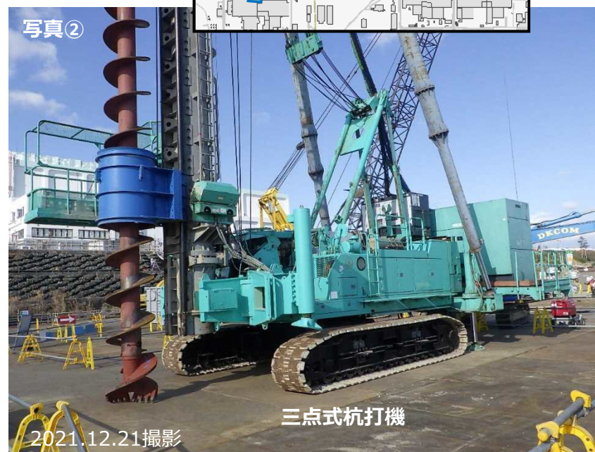
三点式杭打機
