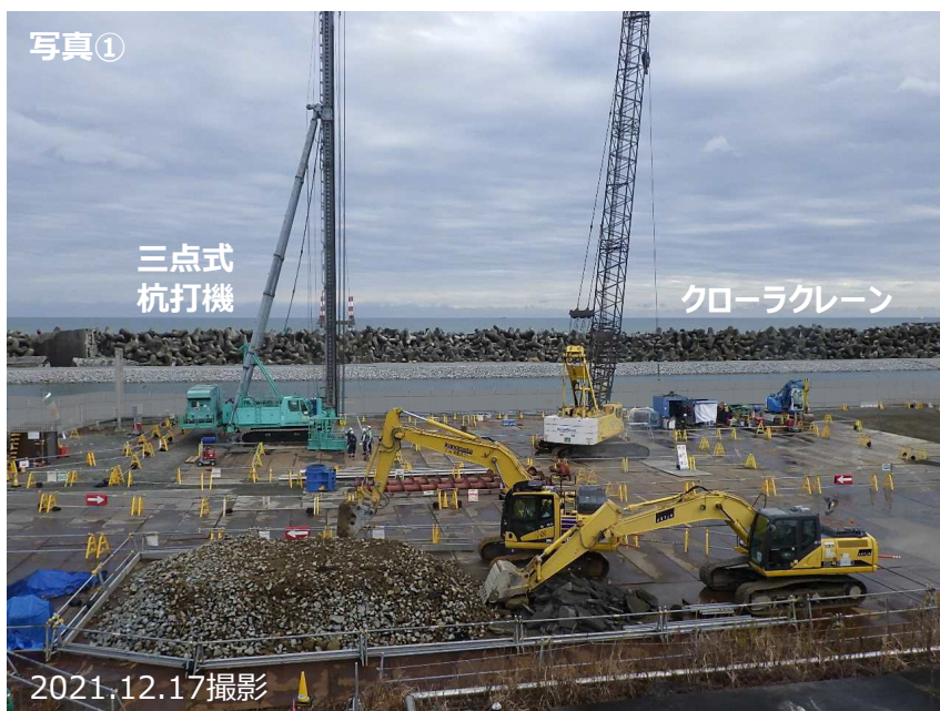
5・6号機取水口付近ヤード全景
