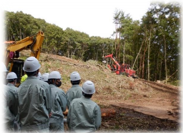
【高性能林業機械による伐採木搬出の様子】
