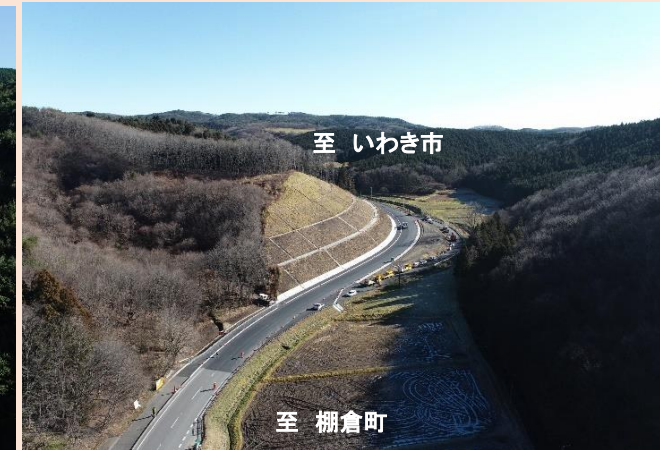
舗装完了状況
