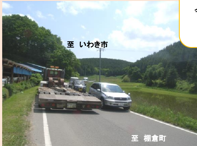
工事着手前(平成25年度)
