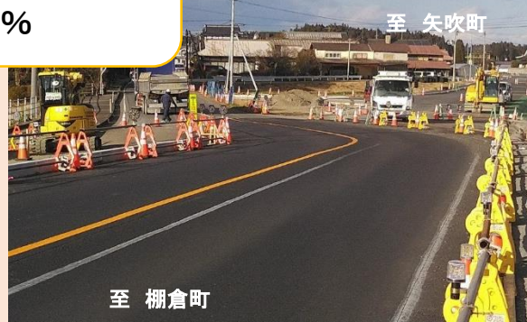
②施工状況
