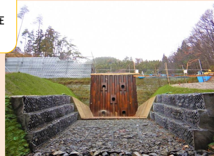
2号堰堤工の状況
