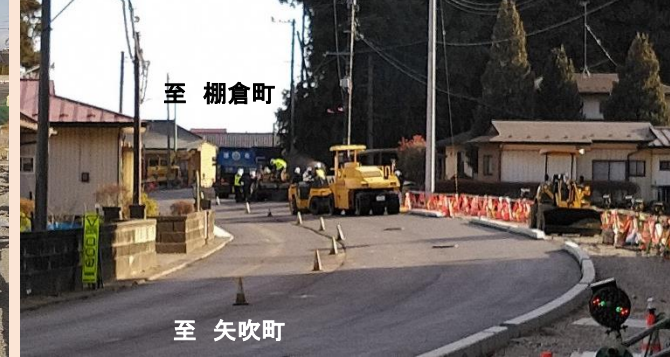
③施工状況
