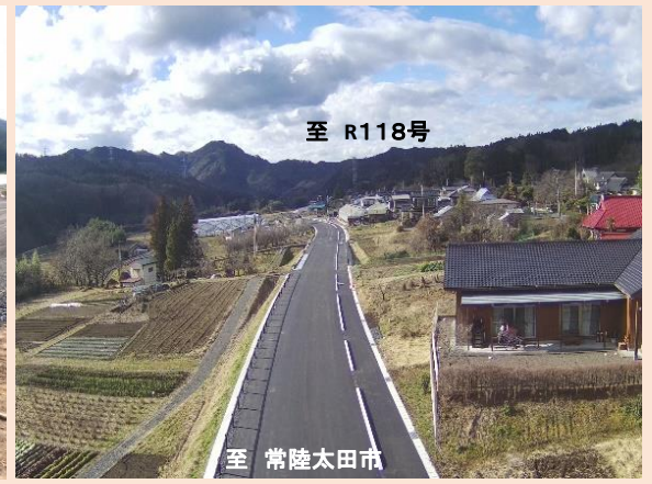
② 2工区 施工状況
