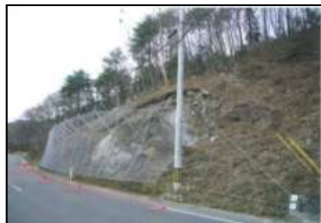
<施工事例：国道114号(浪江町) 落石防護網工>
