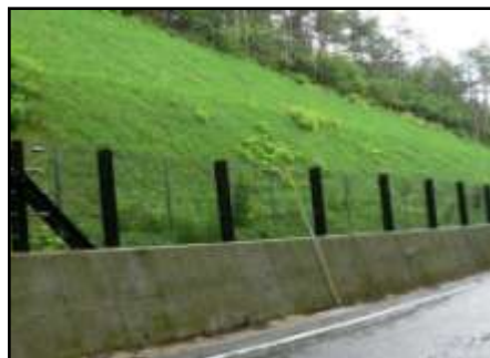
<施工事例：草野大倉鹿島線(南相馬市) 落石防護柵工>
