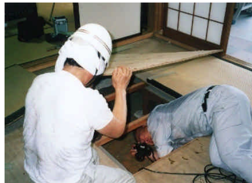
＜木造住宅耐震診断の実施＞
