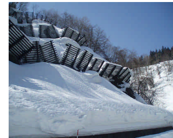
<会津美里町松坂の雪崩を防止する整備事例(国道401号)>
