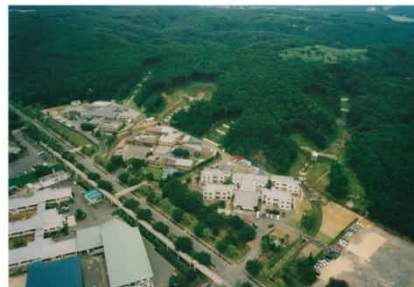
砂防えん堤による土石流対策 平成11年7月完成
