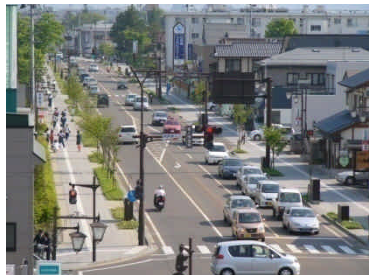
亀賀門田線 追手町工区 (会津若松市) 供用開始後の状況
