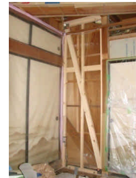
＜耐震改修事例 ：筋交い補強例＞
