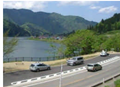
待避所・休憩所づくり (金山町・国道252地区)
