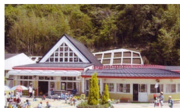
災害時要援護者関連施設（幼稚園） 急傾斜地対策
