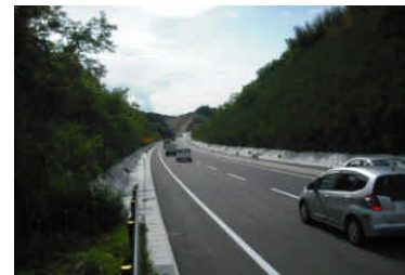
【国道288号 三春西バイパス】
