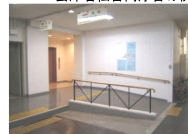
手すり・スロープで段差を解消
