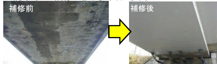
劣化した桁の補修により橋の長寿命化を図ります。
