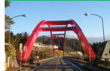
<景観に配慮して橋梁を塗り替えた状況> 国道252号(柳津町)
