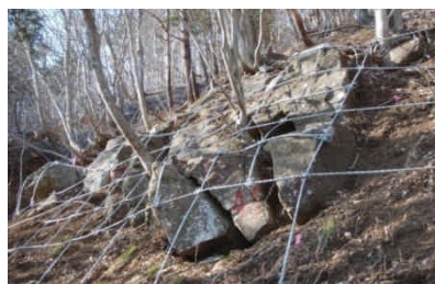
【ロープ掛工】 <落石対策 整備例: 施工後 (斜面の岩塊を固定)>
