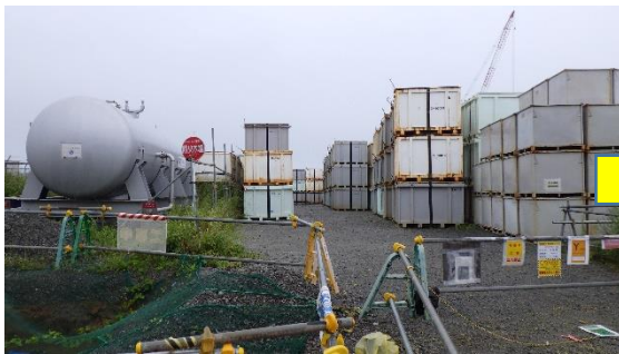
(写真1-1) 一時保管エリアW1の状況① (前回(令和3年8月16日)西側から撮影)
