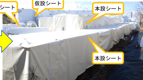
(写真2-2) 一時保管エリアW1のシート養生の 状況②(今回(1月12日)エリア北側を 東側から撮影)
