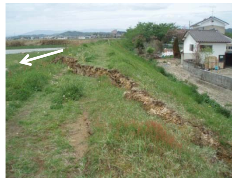
【河川堤防の復旧】 木戸川(檜葉町)等
