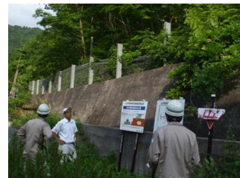
急傾斜施設の点検
