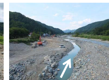
施工予定箇所
