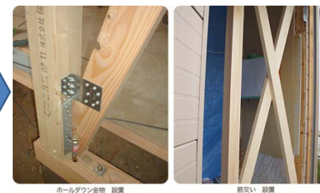
<耐震改修事例：筋交い補強>
