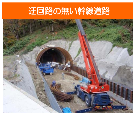
国道252号滝バイパスの状況
