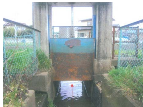
老朽化した樋門の補修
