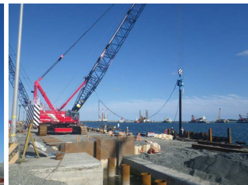
【岸壁の復旧】 相馬港2号ふ頭(相馬市)
