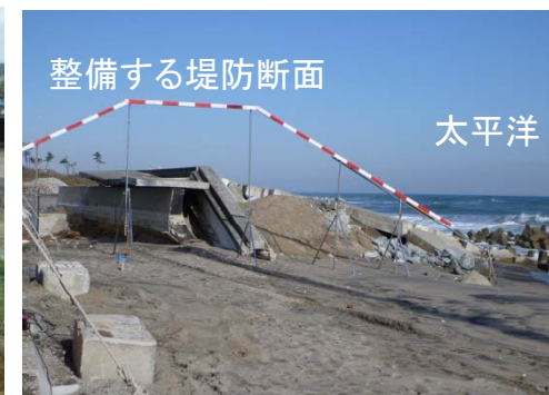
【海岸堤防の復旧】 木崎海岸(新地町)等
