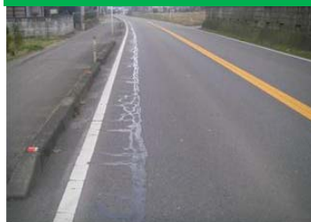
長寿命化対策(舗装補修)
