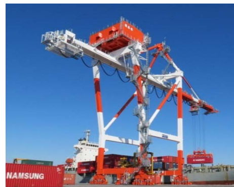
【ガントリークレーンの供用開始】 小名浜港(いわき市)
