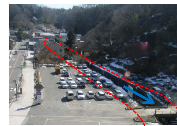
施工予定箇所
