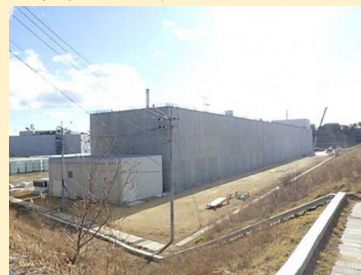
本体工事状況
