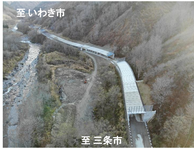
スノーシェッド工事状況
