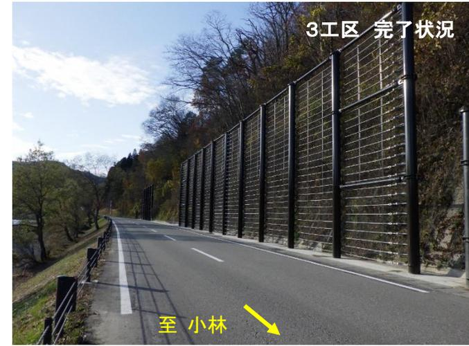
令和3年度は雪崩による冬期通行止めの解消や、通行車両への被害の防止を目的とした雪崩予防柵の整備が完了しました。
