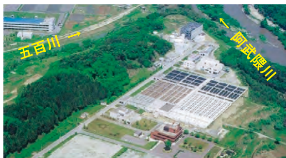
阿武隈川上流流域下水道 県中浄化センター（郡山市）
