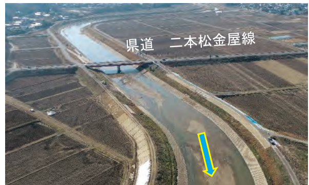
谷田川(郡山市) 河道掘削状況
