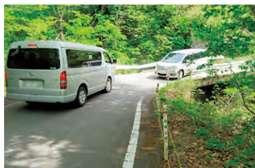
現道の状況 国道401号（昭和村）
