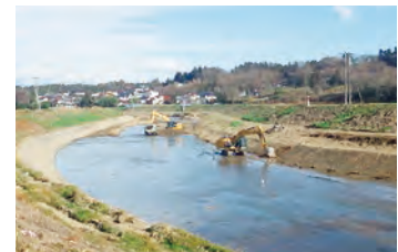
河川の堆砂除去状況
