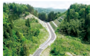
国道459号 藤沢（喜多方市）
