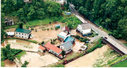
熱塩沢 浸水被害状況
