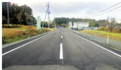
いわき浪江線 舗装補修（大熊町）
