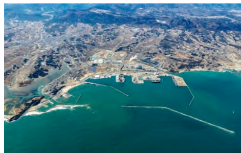
相馬港 防波堤整備 （相馬市、新地町）
