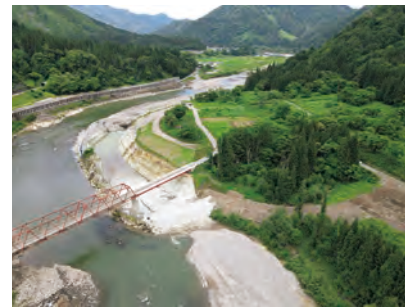
河道掘削の状況 只見川（只見町）
