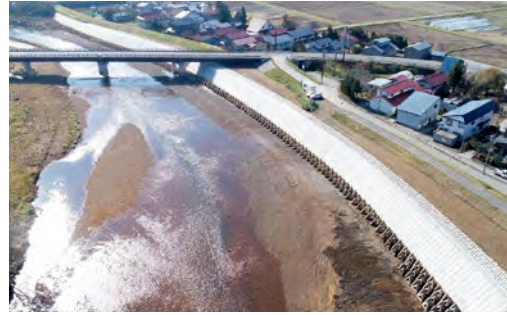
長瀬川整備状況
