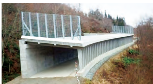
スノーシェッド整備状況 国道289号チバ沢（只見町）
