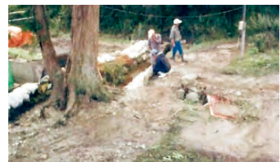
土砂流出の状況
