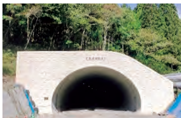
田代トンネル本体工事完了 (令和2年12月)
