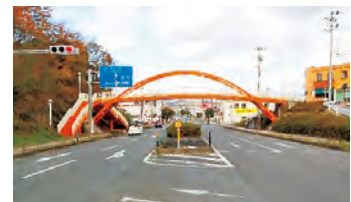
県道小名浜平線 八ツ坂歩道橋 (橋梁補修)
