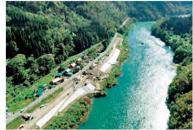
河川堤防の整備状況（只見川）
