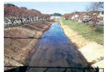
矢田川 河道掘削状況
