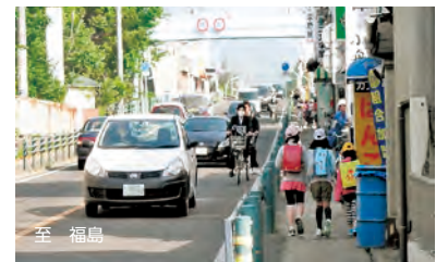
都市計画道路 栄町大笹生線（福島市）
