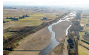
河道掘削状況 濁川（喜多方市）
