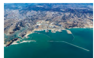
相馬港 防波堤整備 (相馬市、新地町)
