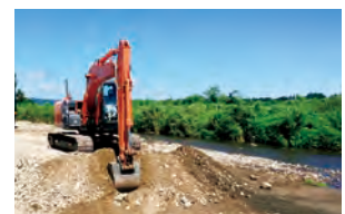
水無川 河道掘削 (南相馬市)
