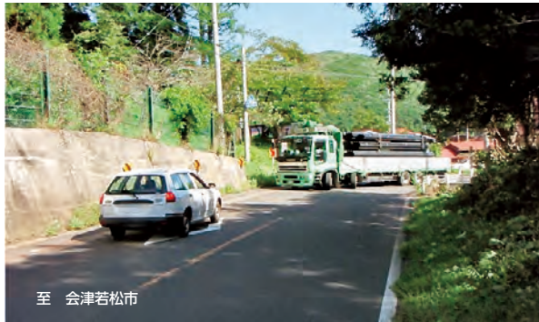
国道294号 福良地内の現道状況
