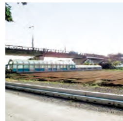
矢吹大橋(矢吹町)
