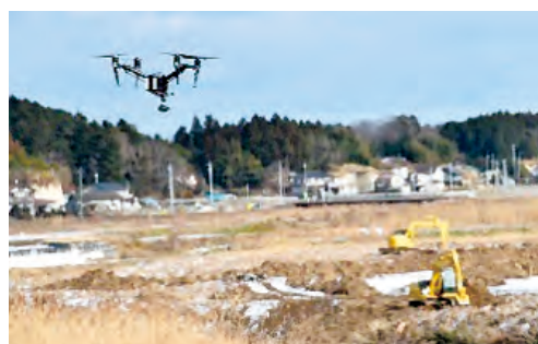
ドローンによる調査
