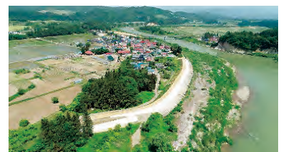
河川堤防の整備状況（只見川）
