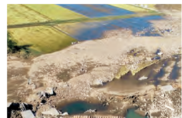
令和元年東日本台風被害状況
