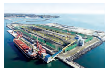
小名浜港東港地区 荷役開始
