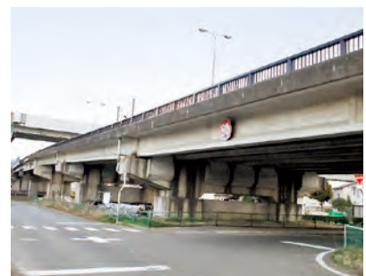
国道115号方木田跨線橋（福島市）
