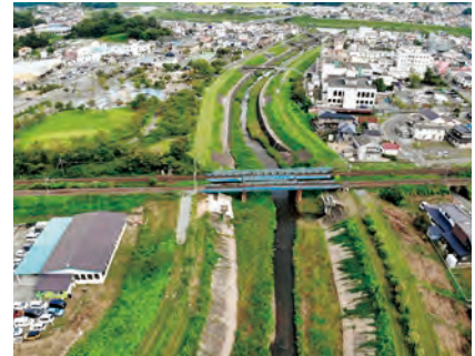
安達太良川河川改修（本宮市）
