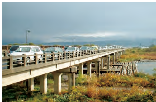
現道の渋滞状況 会津若松三島線 蟹川橋（会津若松市）
