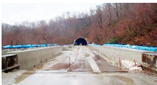
スノーシェルター整備状況 国道289号ナコ沢（只見町）
