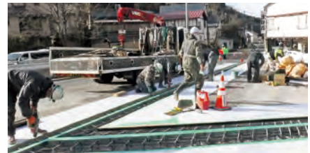
橋梁補修状況 国道459号 高橋橋 (北塩原村)
