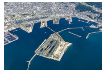
小名浜港東港地区整備状況
