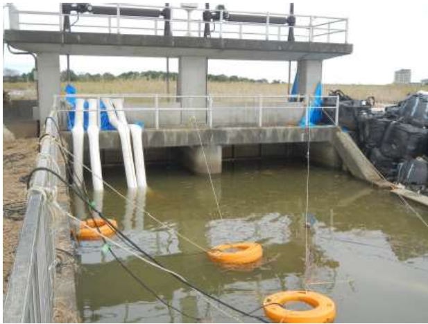
和田地区 排水ポンプ設置（相馬市）
