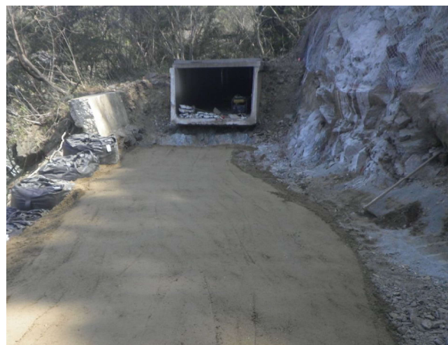
【復旧状況 崩落した土砂を撤去】
