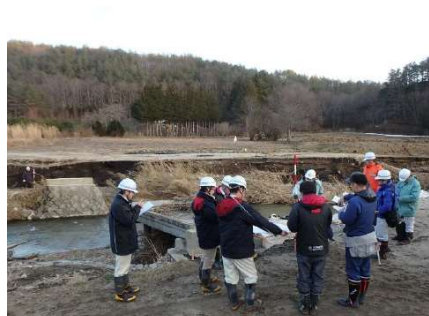
現地査定[橋梁](川内村)
