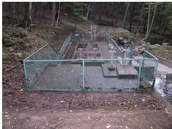
【復旧状況 土砂撤去完了】
