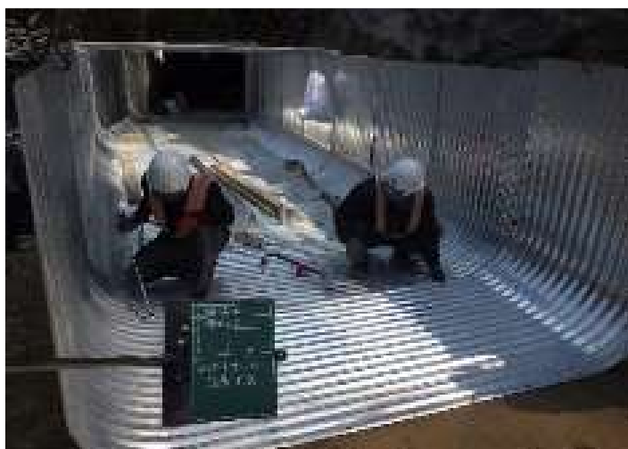
【復旧状況 仮設水路設置】 (コルゲートフリューム)
