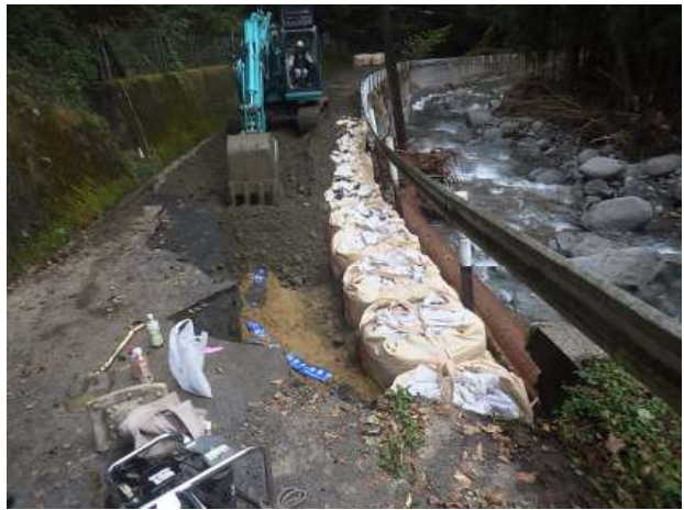
山上地区 営農飲雑用水 仮配管設置（相馬市）
