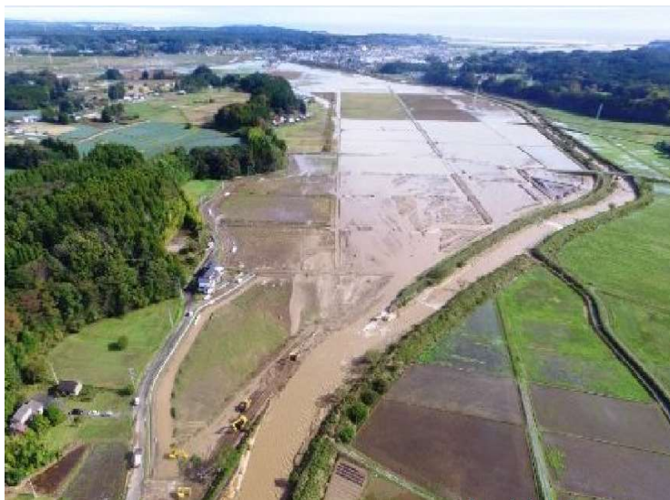
【被災状況 堤防決壊によりほ場へ土砂が流入】
