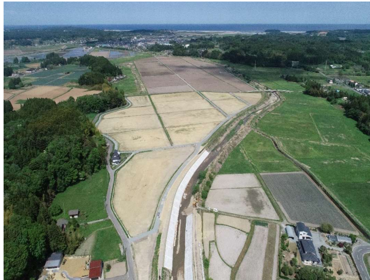
【復旧状況 土砂撤去・整地完了】
