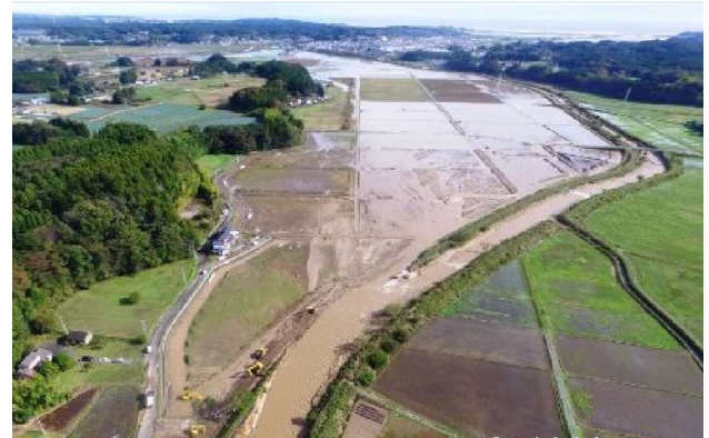
飯崎地区(南相馬市小高区) 東日本大震災と原発事故後、営農再開を目指し、ほ場整備を実施中であったが、小高川の堤防決壊により、ほ場に土砂が流入。
