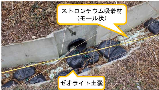
(写真3-2) 一時保管エリアP排水柵の状況(南側から撮影)
