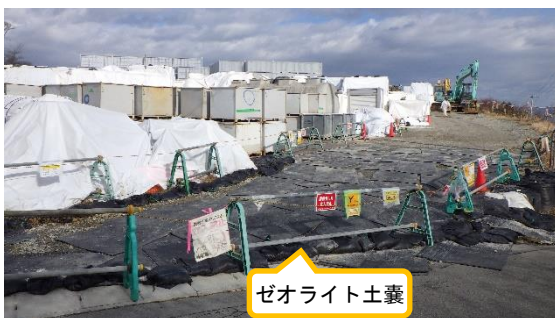
(写真3-1) 一時保管エリアP入口の状況(南側から撮影)
