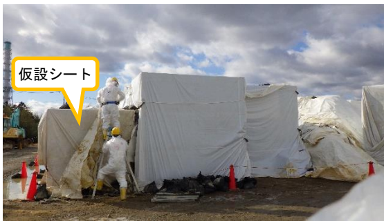
(写真1) 一時保管エリアP2の仮設シート外し作業の状況(北側から撮影)
