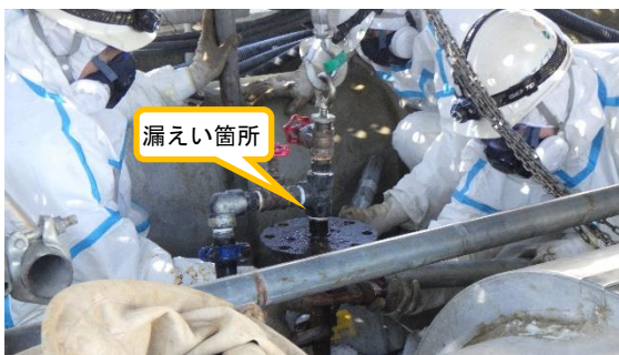
(写真1-2) ブライン漏えい箇所の補修作業の状況 (南東側から撮影)
