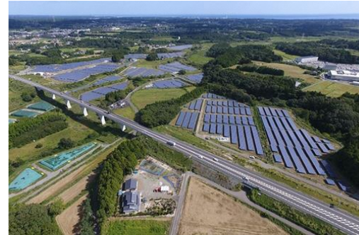
大熊エネルギー・メガソーラー発電所
