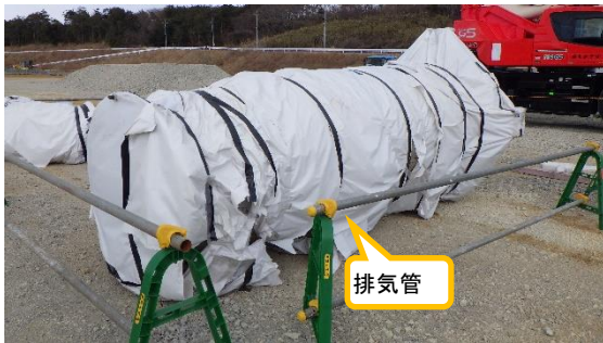
(写真4) 現場に運びこまれた排気管の状況
