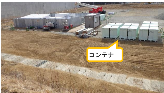
(写真3-1) 細断エリアの状況 (東側から撮影)
