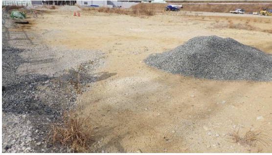
(写真1) 建設現場の状況 (南西側から撮影)
