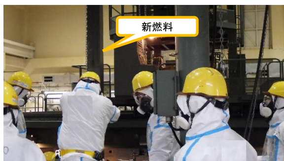
(写真1-2) チェーンブロックによる新燃料の 吊り上げ状況 (東側から撮影)
