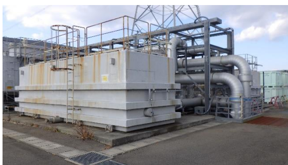
(写真4-3) ブラインを補充したブライントank (令和4年1月27日撮影)
