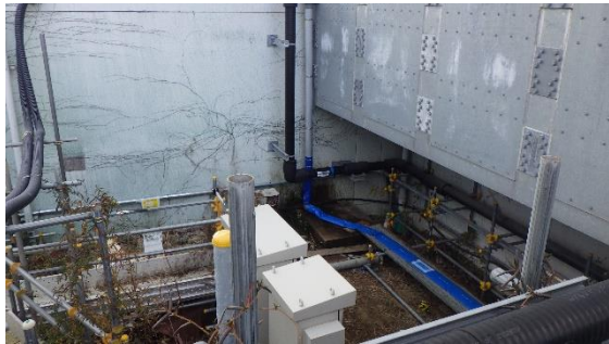
(写真 3 - 1) 仮設ホースの敷設状況
