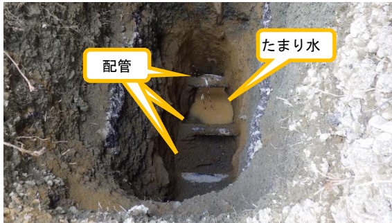
(写真 3 - 2) 試掘箇所底部の状況
