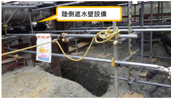
(写真 3 - 1) 試掘箇所の状況
