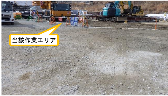
(写真1) 5号機南東側の堆積物取扱作業エリア入口付近の状況
