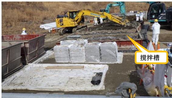
(写真3) 攪拌作業の状況 (重機2台により攪拌を実施)
