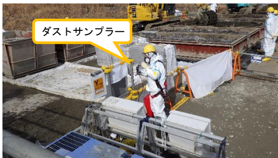
(写真4) ダストサンプラーの準備状況 (攪拌作業現場2箇所で作業中及び作業前後の測定を実施)
