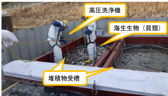
(写真2) 海生生物の除去作業の状況 (堆積物受槽のスクリーン上で高圧洗浄機を使用して実施)
