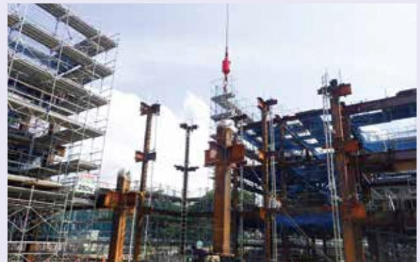
鉄骨柱の設置状況
