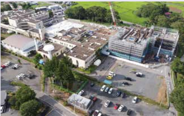
既存病院の南側上空から（令和3年8月）
