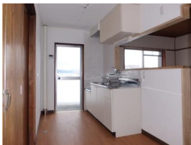
台所：対面キッチン(流し台交換) 和室との床段差解消、給湯 設備追加
