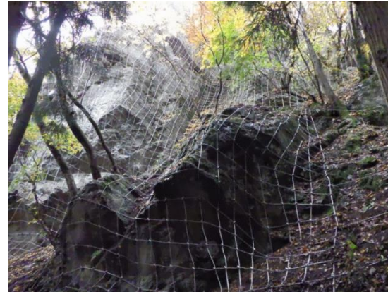
ロープネット工
