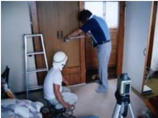
耐震改修の状況
