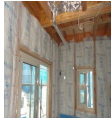
断熱改修の状況
