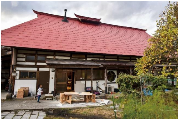
空き家の改修事例（「住んでふくしま」 空き家対策総合支援事業）
