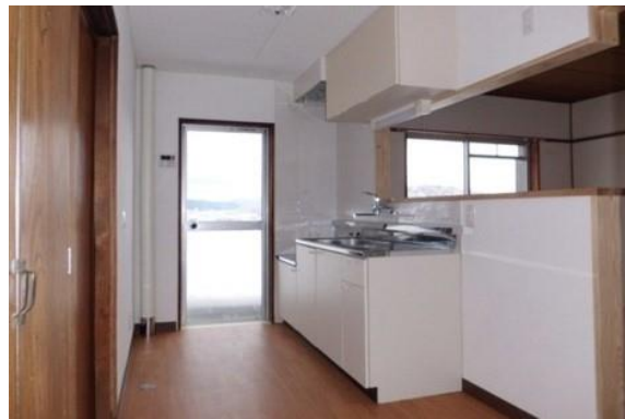
公営住宅等ストック総合改善事業の事例 (内部改善)
