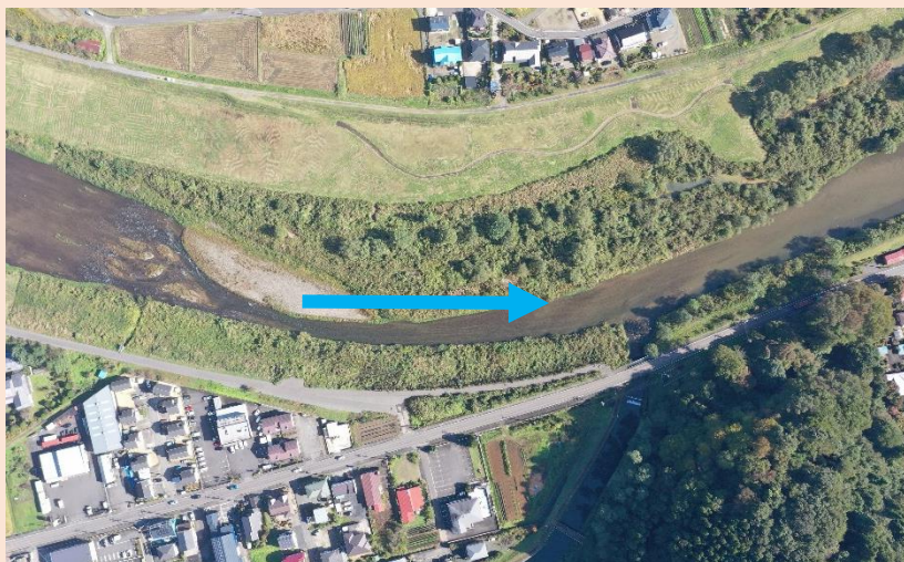
施工前の状況
