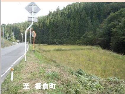
工事着手前(平成22年度)
