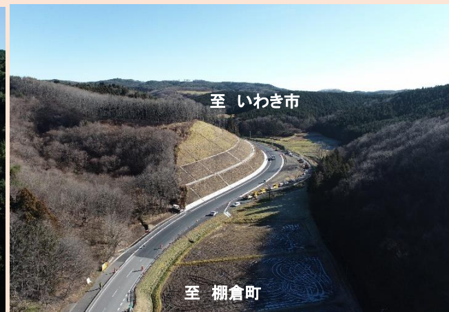
舗装完了状況
