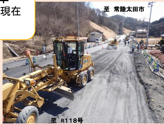
① 2工区 施工状況
