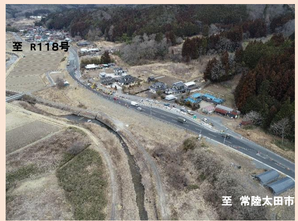
② 3工区 施工状況
