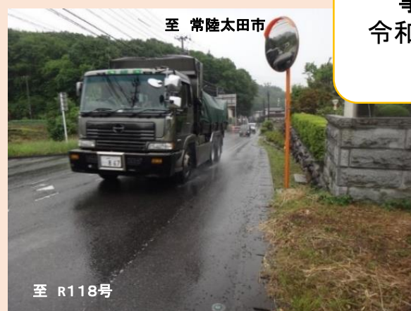
工事着手前(平成26年度)
