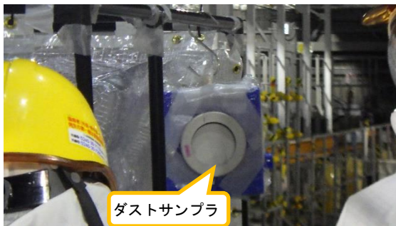
(写真3-3) ハウス外に設置されたダストサンプラの状況
