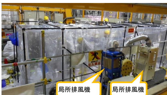
(写真3-1) ハウス内のダスト濃度上昇防止対策 の状況
