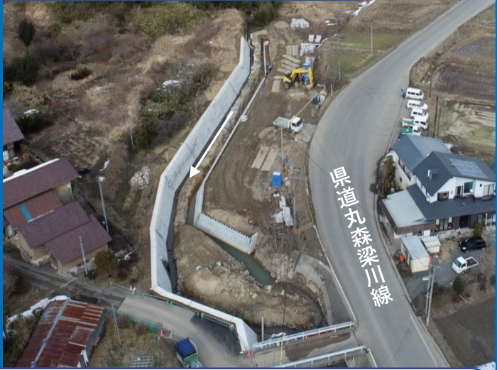
② ⑤除石地区：護岸工事施工
