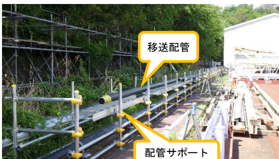
(写真2-1) 中継タンク南西側における移送配管の敷設状況 (東側から撮影)
