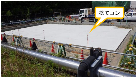
(写真2) 中継タンク設置予定地の捨てコン打設状況 (北東側から撮影)
