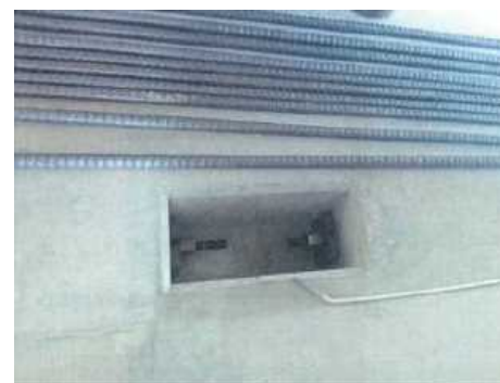
切り欠き部のモルタル充填
