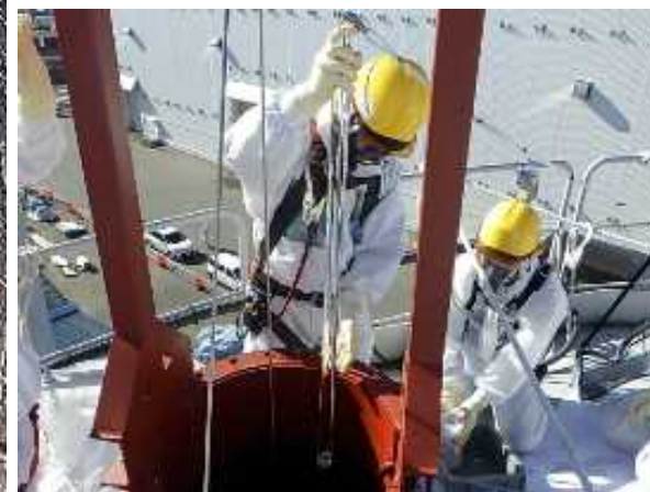
攪拌実証試験当日の採水の様子
