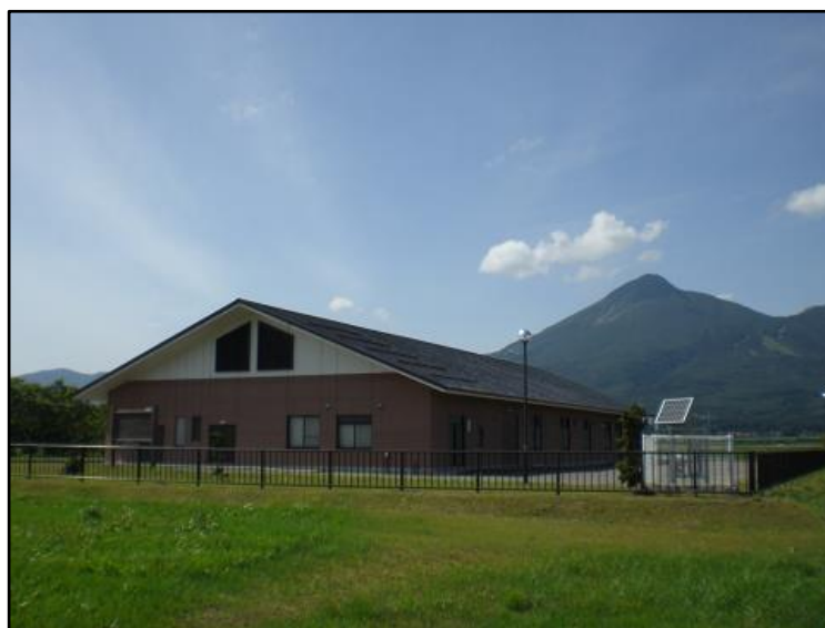
湖岸地区農業集落排水施設
