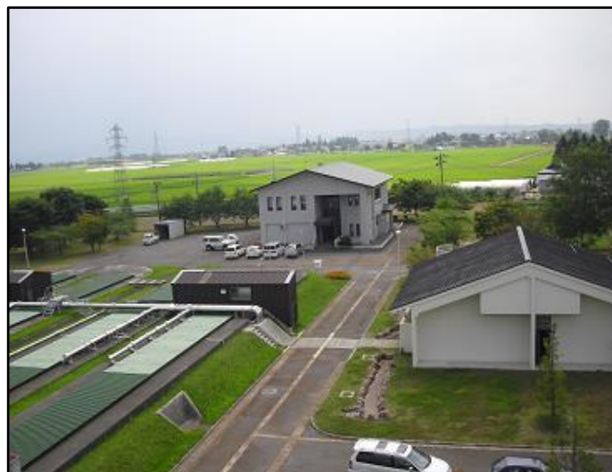
猪苗代浄化センター
