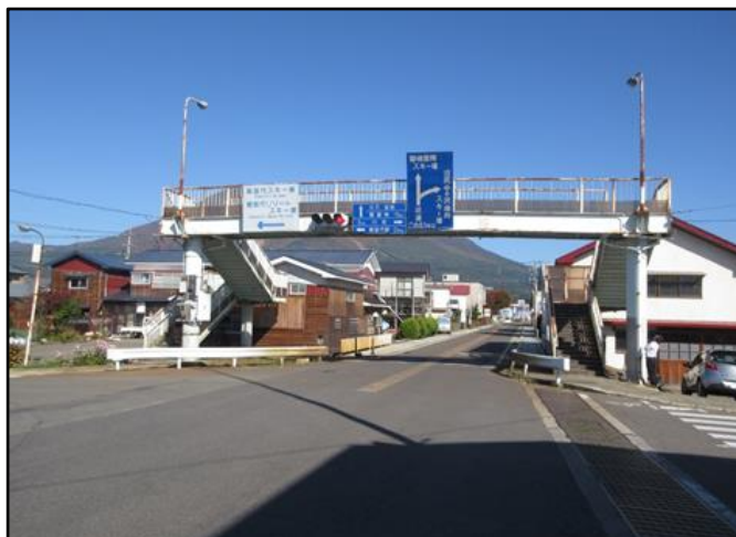
千代田歩道橋
