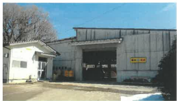
《堆肥センター》
