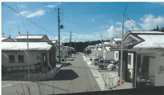
《災害公営住宅 横堀平団地》
