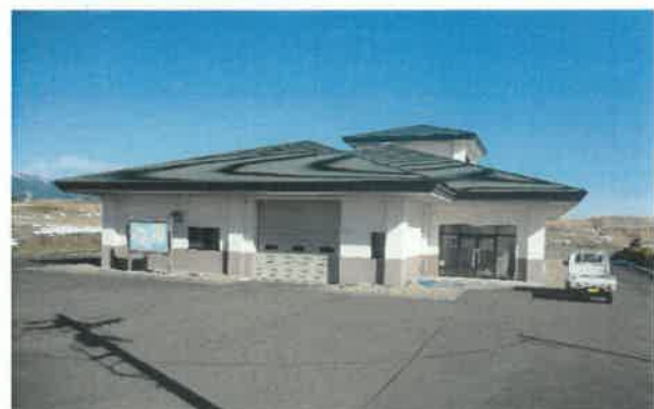
《玉井第2処理場》
