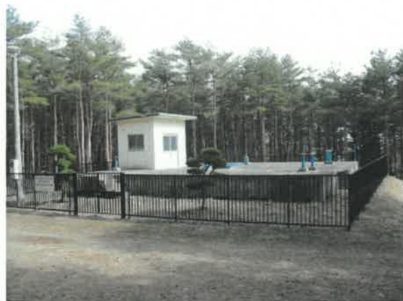
《高区第1配水池・第4水源系》
