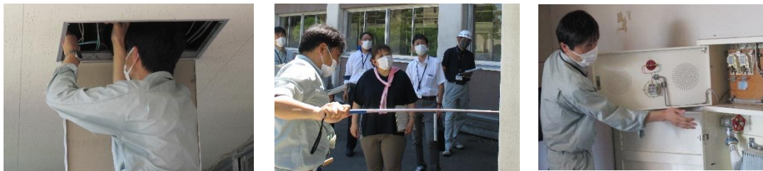
※ 市の技術職員による施設点検の様子
