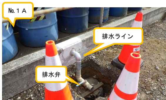
(写真1-1) 排水ラインの状況 (No.1 A) (令和4年2月22日撮影)
