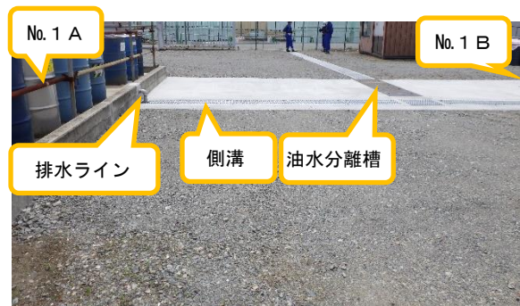
(写真1-2) 側溝等の設置状況 (No.1 A及びB) (令和4年4月28日撮影)
