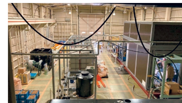
福島支店試験棟内景
