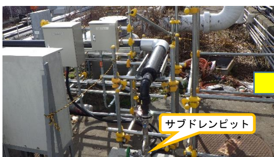
(写真1-1) サブドレンピットNo.72の状況 (5号機タービン建屋東側) (前回(令和4年1月18日)撮影)
