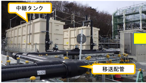
(写真2-1) 中継タンク周囲の状況 (5号機タービン建屋南側) (前回(令和4年1月18日)撮影)
