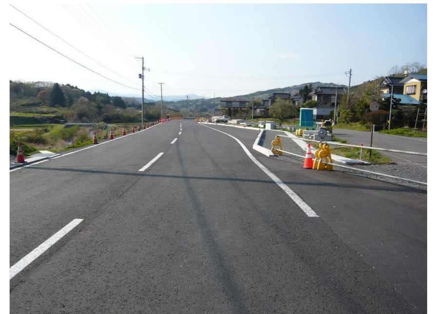
③ 3工区の工事状況
