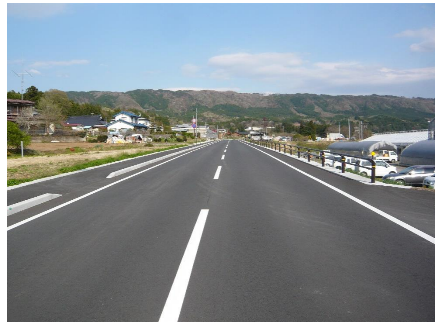
② 2工区整備完了状況
