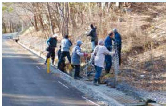
【ワイヤーメッシュ柵の設置】
