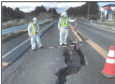
相馬新地線 (新地町駒ヶ嶺地内)
