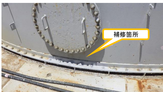
(写真4) I 2タンクの水の滴下を確認した箇所の止水材による補修の状況の例 (タンクの南東側)
