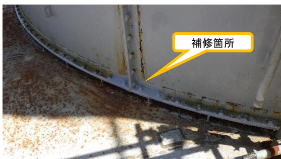
(写真5) I 3タンクの水の滴下を確認した箇所の止水材による補修の状況の例 (タンクの西側)
