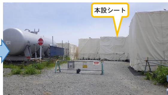
(写真1-2) 一時保管エリアW1の本設シート養生の状況(1)(今回(6月1日)西側から撮影)
