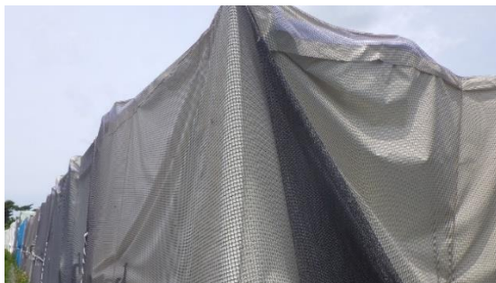
(写真5) ネット設置の状況
