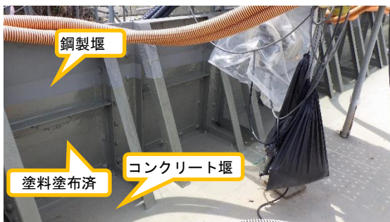
(写真 3) 堰の補修状況
