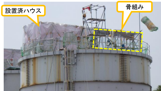
(写真1-2) D2タンク上部の状況 (北側から撮影)
