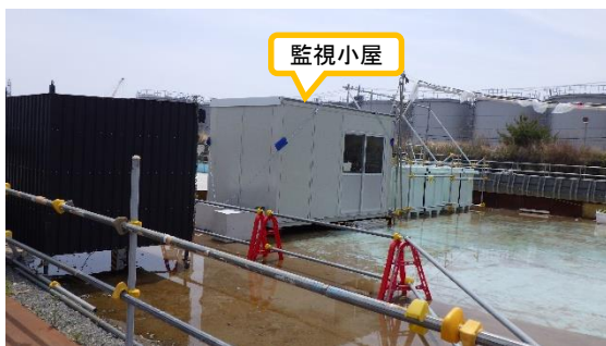
(写真2-1) 監視小屋の外観 (北西側から撮影)
